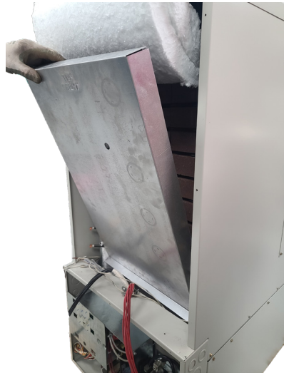
FIGURE 8 POSITIONNEMENT DU CONDUIT D'AIR
